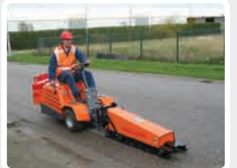
Roadblaster (f. Markierungsarbeiten)
